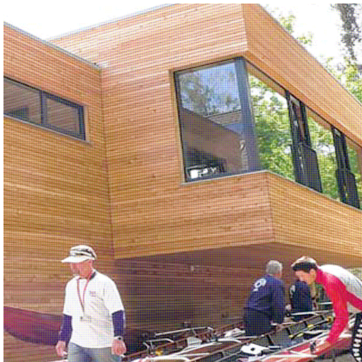
Bei dem neuen Bootshaus der Ruder-Union an der Scharfen Lanke 71-73 handelt es sich um ein zweigeschossiges Gebäude mit Holzverkleidung.
